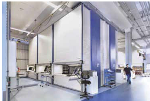
Durch die kompakte und vertikal höhenoptimierte Lagerung der unterschiedlich großen Artikel entsteht eine optimale Raumausnutzung.
